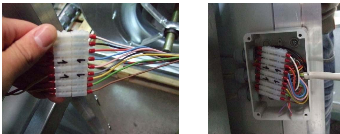
56. ábra Csatlakozók a kapcsolódobozban
